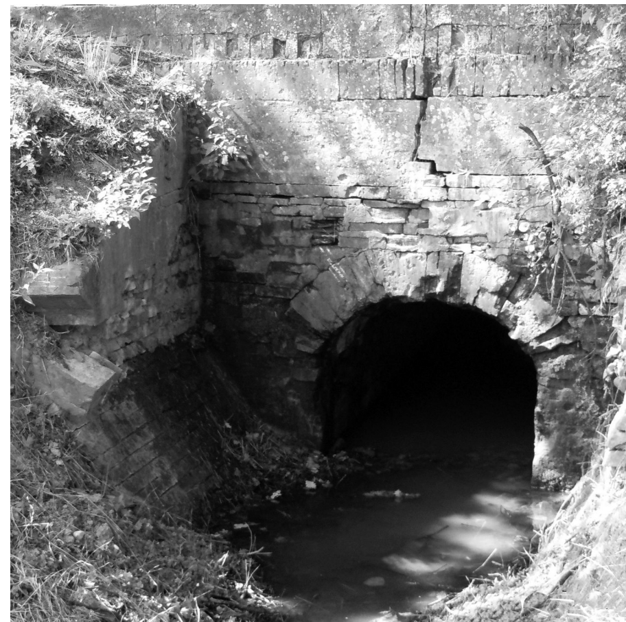
Chiavica lungo via stradella alla confluenza di via ricci (battirame). Il manufatto con volta di mattoni ha origine ottocentesca, infatti nel novecento si usavano tubi di cemento. (foto G. Corradini)
